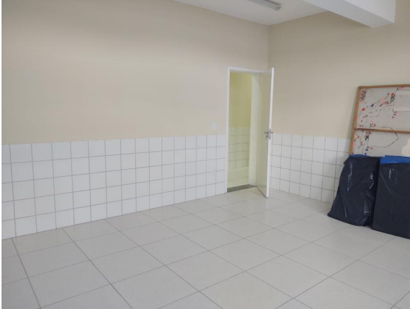
1 – Limpeza de obra
