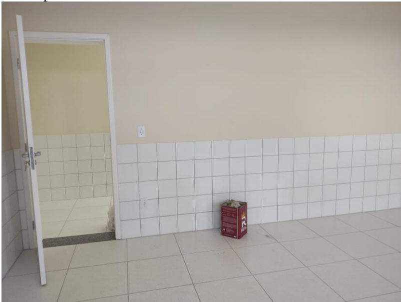
2 – Limpeza de obra
